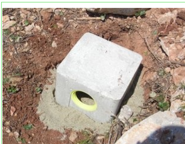
Photo 5 : Positionnement du caisson dans le trou ©Pauline Demonfaucon
