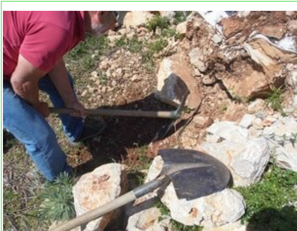
Photo 3 : Réalisation du trou pour poser le caisson ©Pauline Demonfaucon
