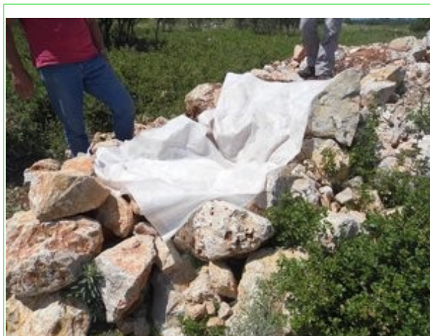
Photo 10 : Installation du géotextile ©Pauline Demonfaucon
