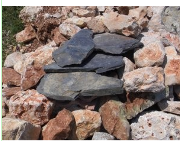
Photo 13 : Installation des ardoises et des dernières pierres ©Pauline Demonfaucon
