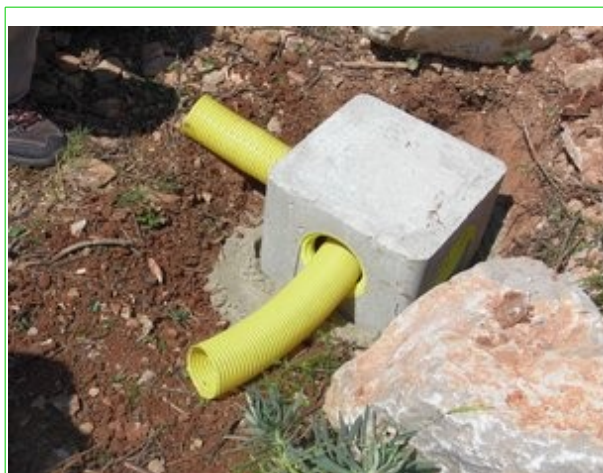
Photo 6 : Mise en place des gaines dans le caisson ©Pauline Demonfaucon
