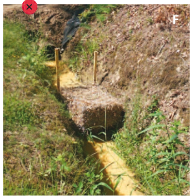
E, F - Bottes de paille insérées dans un gabion et mises en place en aval du point de rejet. La mauvaise installation de ces gabions rend les dispositifs inefficaces voire contre-productifs.
