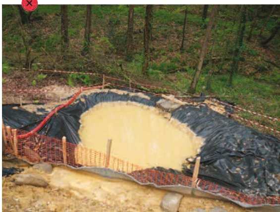
Piège à sédiments de forme ronde, inadaptée à la décantation des sédiments.
