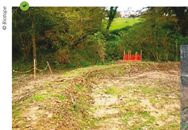
Merlon en bas de pente, équipé d'une surverse (identifiée en orange). Il protège une berge défrichée et dirige l'eau vers un milieu végétalisé
