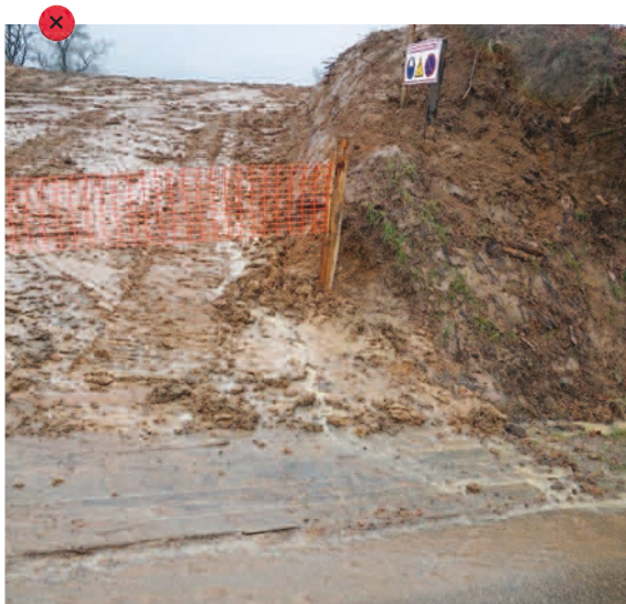
Accès au chantier non aménagé.
