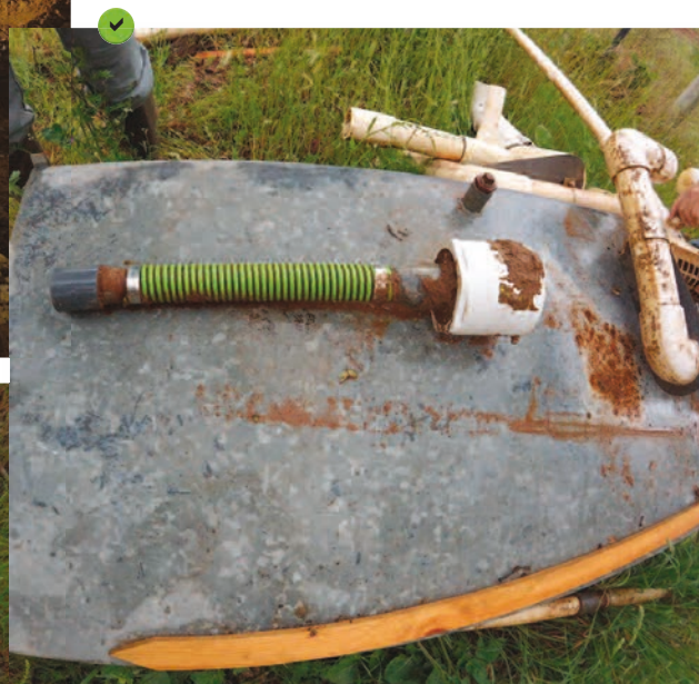
Installation d'un skimmer au sein d'un bassin de décantation provisoire.
