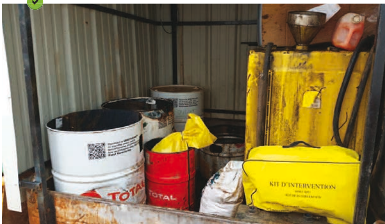
Exemple d'une aire de stockage des matériaux polluants, constituée d'un container/bungalow étanche associé à un kit anti-pollution. Certains produits sont isolés du sol et disposés sur des bacs de rétention.
