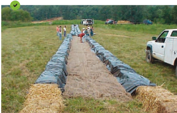
Configuration de traitement pour un pompage et rejet : photo de gauche vue d'aval avec la toile en jute pour retenir les sédiments coagulés, et la photo de droite avec les blocs de PAM attachés le long du fossé de traitement.
