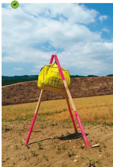
Exemple d'un kit anti-pollution isolé du sol.
