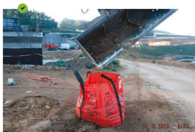
Exemple de la récupération de terres polluées aux hydrocarbures et de leur stockage dans un big bag étanche.
