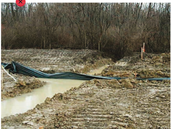
Ne pas installer de barrières de rétention en travers des cours d'eau.
