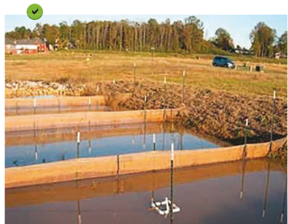
Bassin de décantation dont les talus sont décaissés et végétalisés. Équipement : chicanes en toile de jute fixée à des piquets en acier et vidangeur flottant de type « skimmer ».
