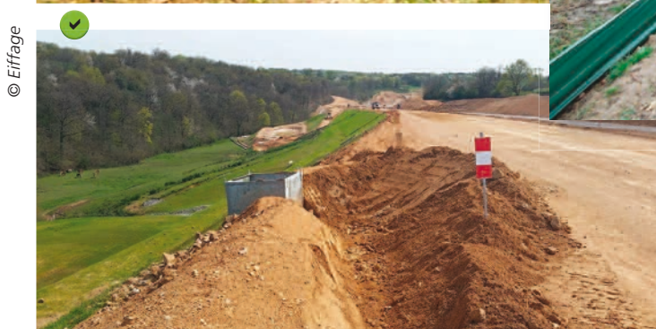
Fossé de collecte des écoulements superficiels.
