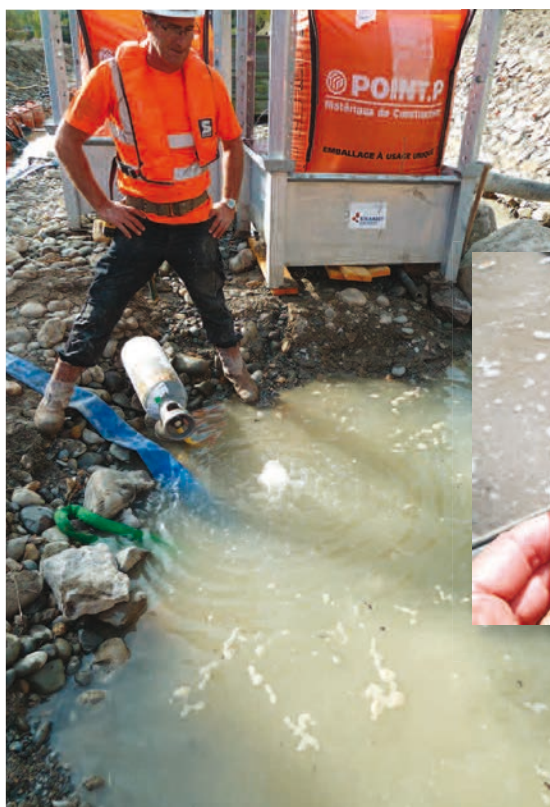
Injection de CO 2 dans une eau polluée par des laitances béton.
