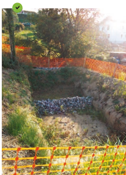
Barrière perméable réalisée à l'aide d'un tas de granulats grossiers.
