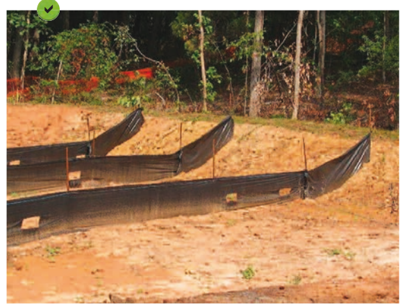
Fixation correcte des barrières géotextile.
