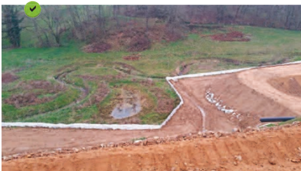
Barrière de rétention longeant un cours d'eau.
