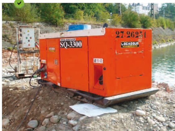
Mise en place d'un géotextile absorbant au point d'alimentation en essence des groupes électrogènes.
