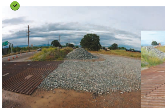
Fosse drainante et grille métallique ondulée.
