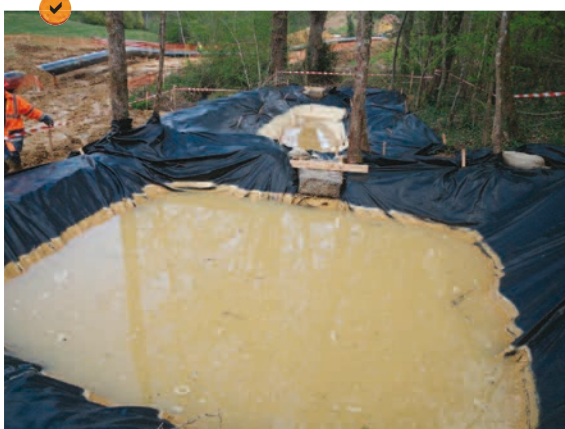
Dispositif de surverse à gabion de paille.
