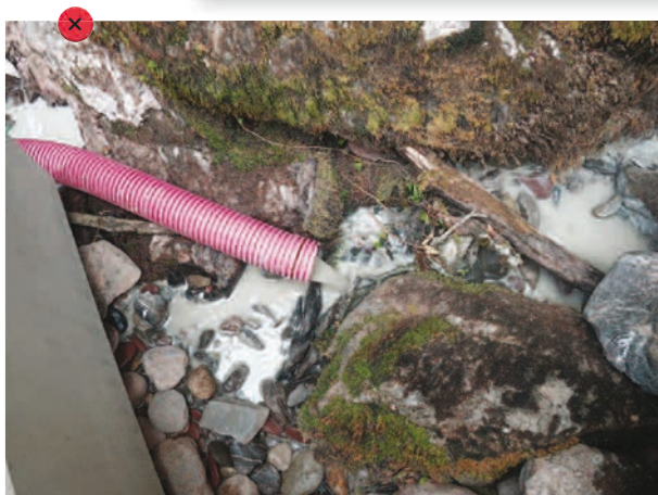
Rejet de laitance béton en milieu naturel.
