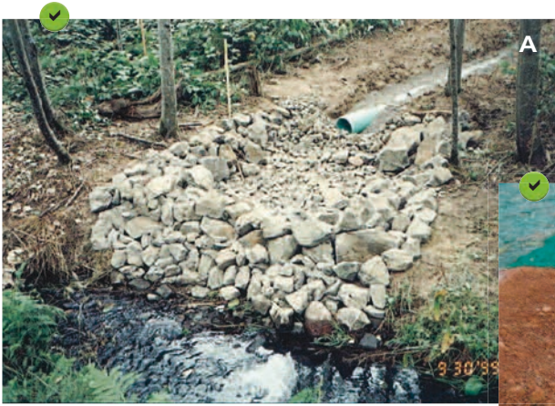
A, B, C - Dispositifs temporaires de protection des points de rejet à l'aide de tas de graviers et de blocs installés en amont du lit mouillé des cours d'eau. Attention toutefois à ne pas dégrader les berges.
