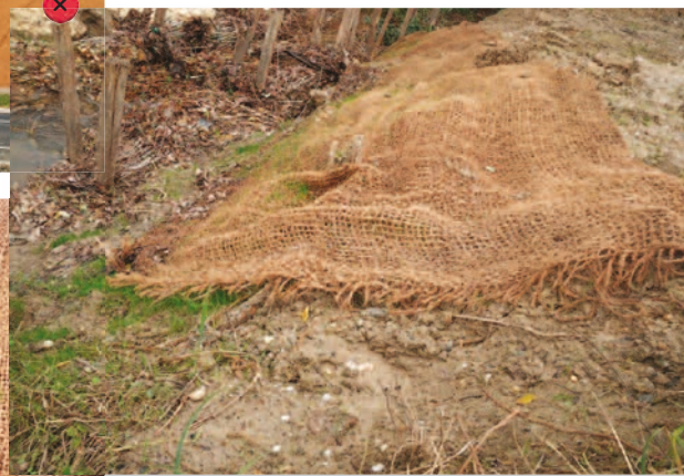
Ancrage insuffisant du filet en amont.
