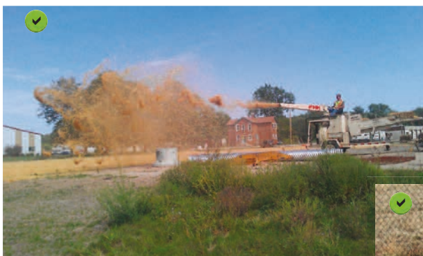
Exemple d'un paillage en cours.
