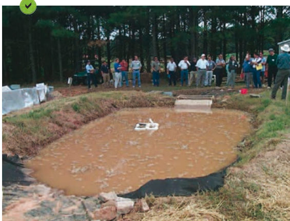
Piège à sédiments avec berges végétalisées.
