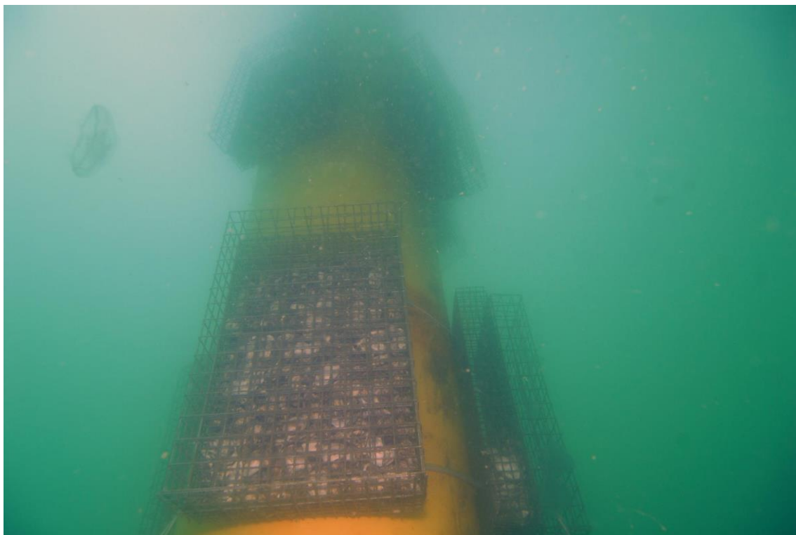
KEPCO : Biohut cerclés autour des pieux de la plateforme (R. Dubas, Ecocean ©)
