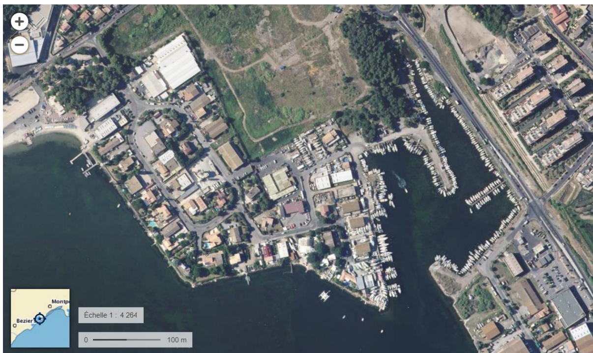
Figure 23 : Darse du lieu-dit « Port Suttel » utilisée illégalement par les plaisanciers sur la lagune de Thau
