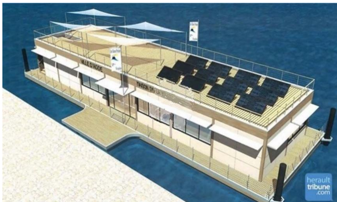
Figure 26 : Exemple de construction entièrement flottante qui pourrait être utilisée pour accueillir la future maison de la mer, on peut observer les poteaux de guidage (en noir) permettant de faire coulisser la structure en fonction de la profondeur d'eau.
